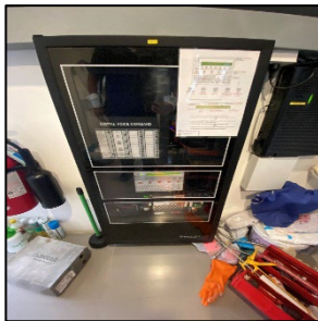
ภาพที่ 2.1-11 ระบบแจ้งเตือนเหตุเพลิงไหม้
