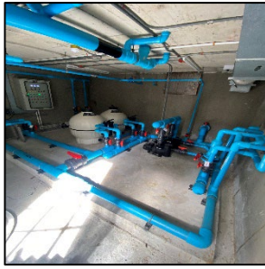
ภาพที่ 2.1-21 ระบบกรองสระว่ายน้ำ
