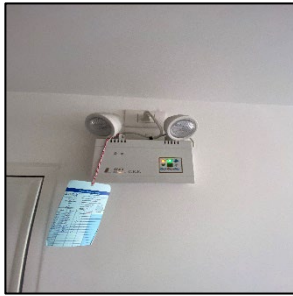
ภาพที่ 2.1-16 ระบบแสงสว่างสำรอง
